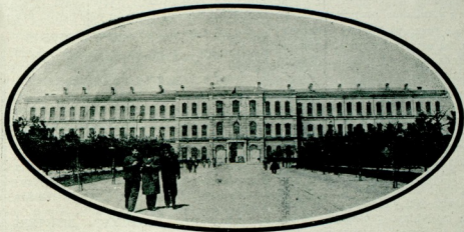
İstanbul Üniversitesi merkez binası
